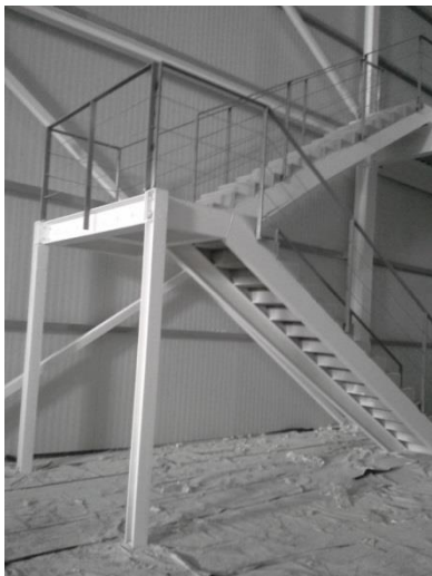
Protección de estructura de escaleras con PROMAPAINTE®-SC4
